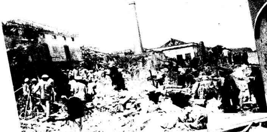
EXPLOSION EN UN LABORATORIO. —Estado en que quedó uno de los siete edificios que desaparecieron al provocarse una terrible explosión en el Laboratorio Naval del Brasil, en cuya hecatombe murieron más de cincuenta trabajadores y hubo un gran número de heridos.
